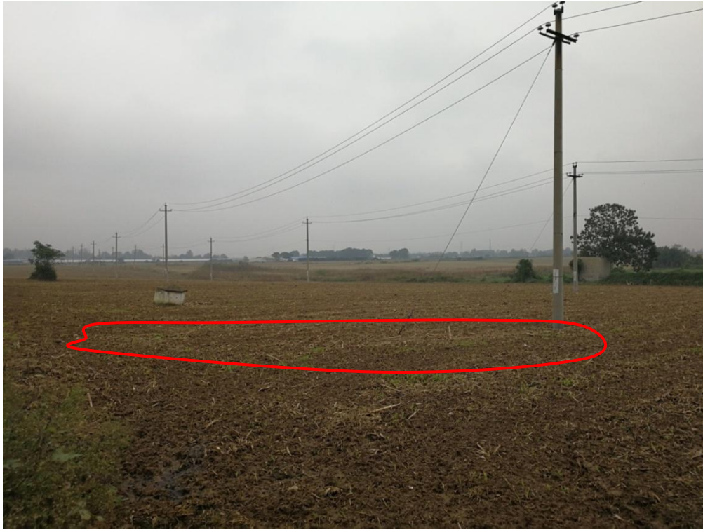
照片 6-1 地面塌陷局部
