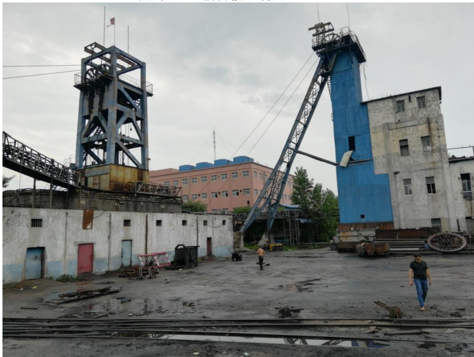
照片 6-9 主斜井工业场地（镜向 160°）
