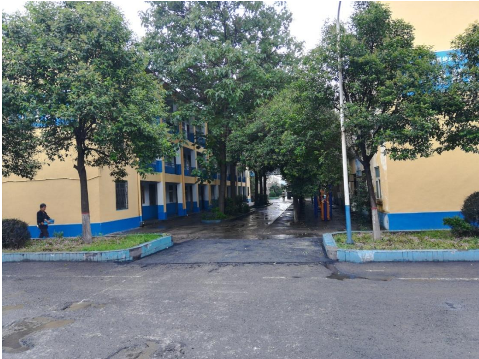
照片 6-8 宿舍楼（镜向 270°）
