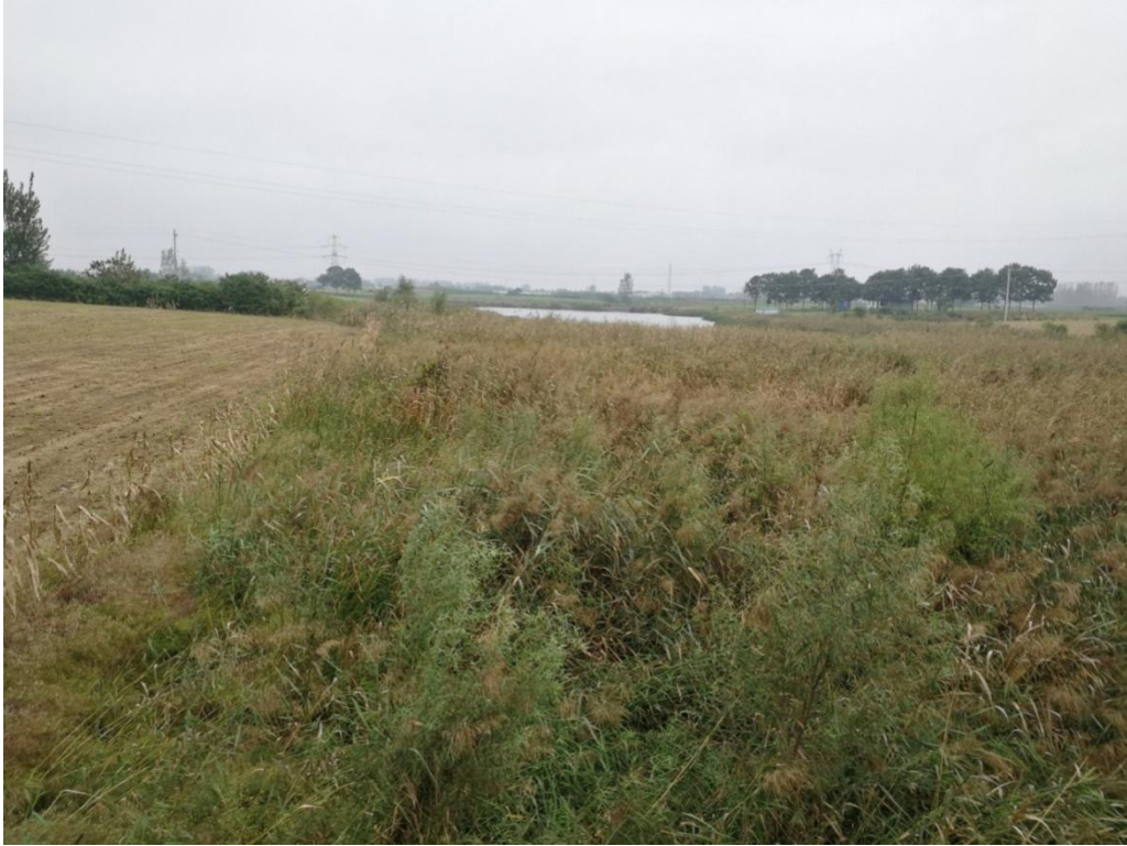
照片 6-3 采空区地面塌陷
