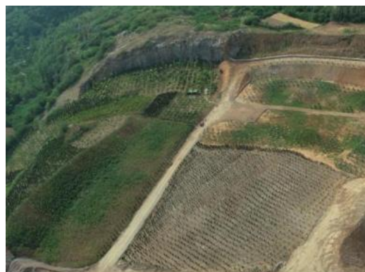
照片 5-11 矿山东北部废弃采坑治理效果
