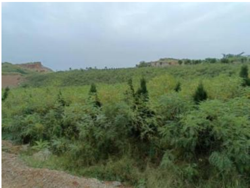
照片 5-10 矿山东北部废弃采坑治理效果
