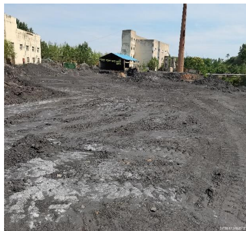
照片 6-9 曹跃工业广场储煤场
