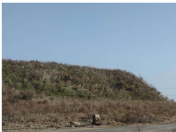
照片 6-6 曹跃矸石堆边坡现状
