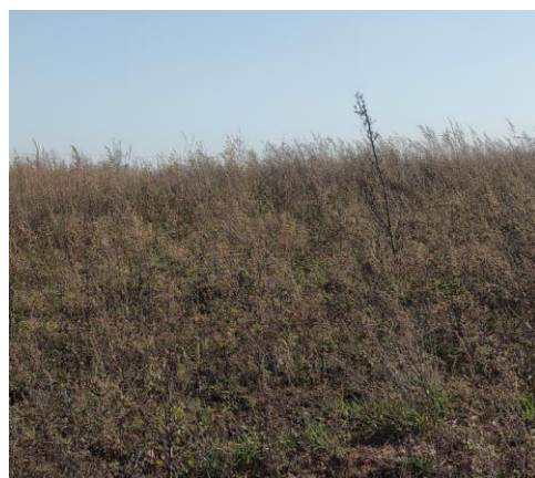
照片 6-7 曹跃矸石堆顶部现状
