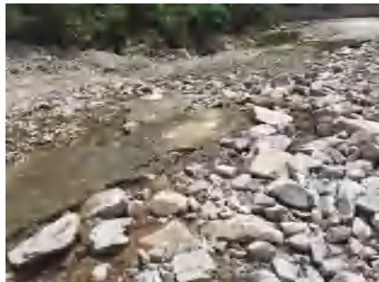
照片 7-4 矿区道路
