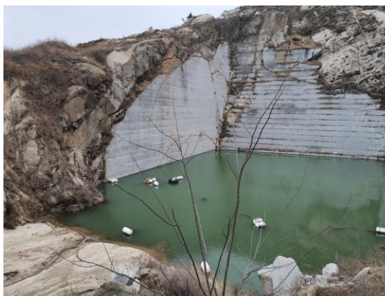
照片 5-6 露天采场形成采坑
