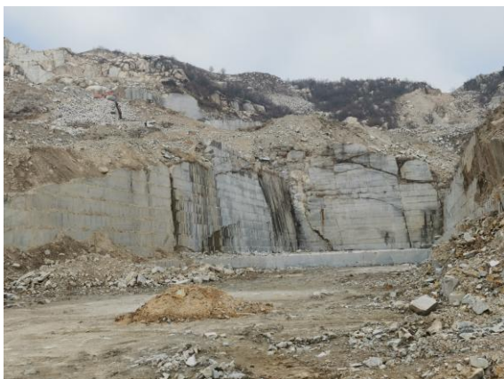
照片 5-3 露天采场现状 1
