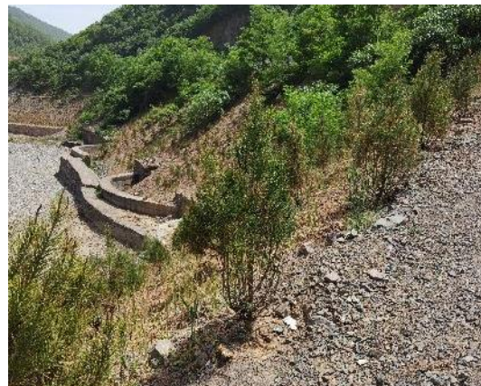
照片 7-9 工业场地 1 东侧修挡墙植树效果
