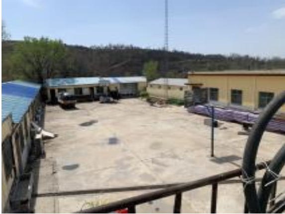
照片 6-1 副井工业场地
