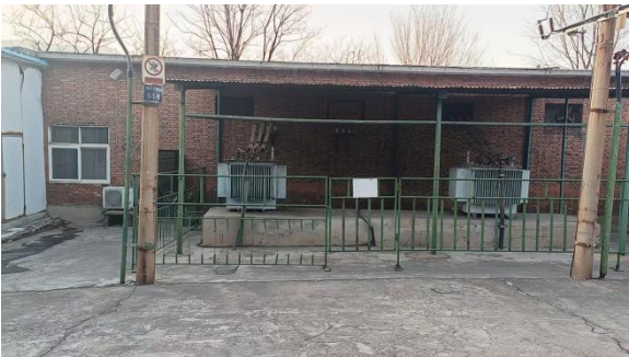
照片 6-5-1 公用设施用地照片 1
