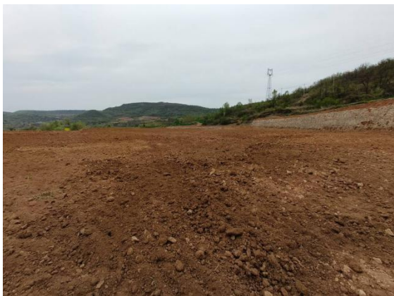
照片 6-2-2 1 号塌陷区治理效果
