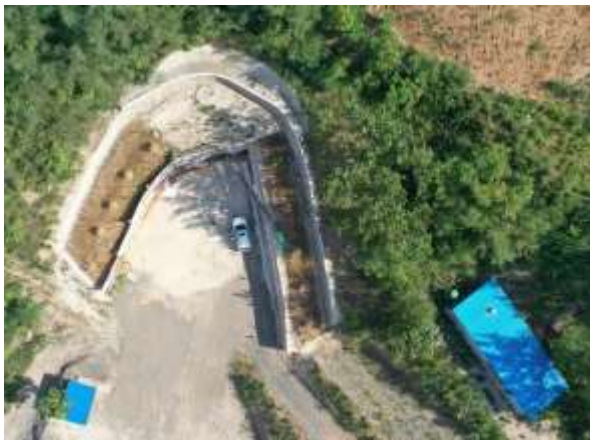
照片 7-1 现状 PD550 工业场地航拍图
