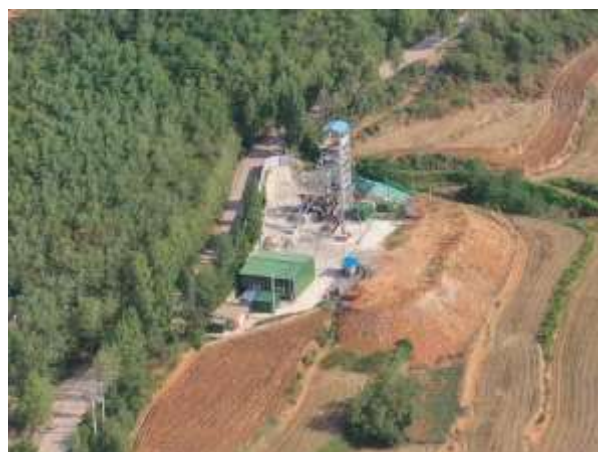
照片 7-6 现状 SJ751 工业场地
