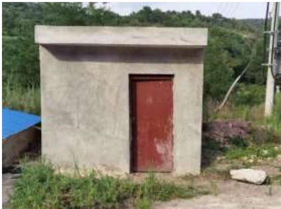
照片 8-1 矿山自备水泵房
