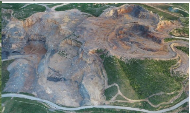
照片 1-6 露天采场 CK2 (由南向北)
