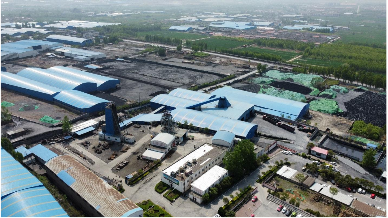
照片 1-7 工业广场无人机航拍照片
