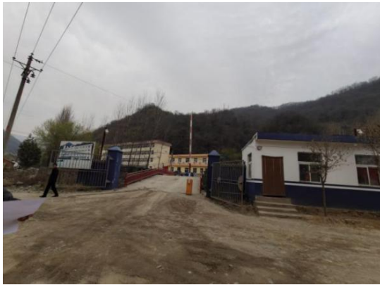
图 6-14 办公生活区（坡面已治理）
