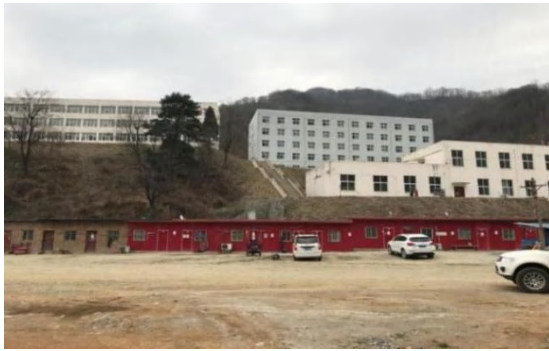
图 6-12PD991 工业场地（坡面已治理）
