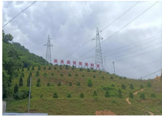
图 6-13PD730 工业场地（坡面已治理）
