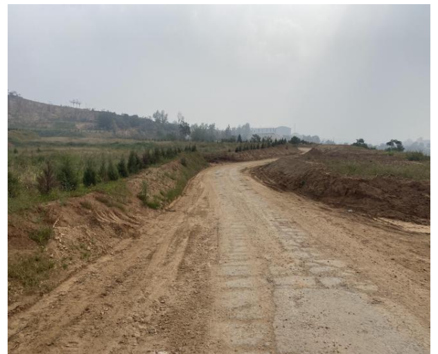
照片 5-7 矿区道路现状
