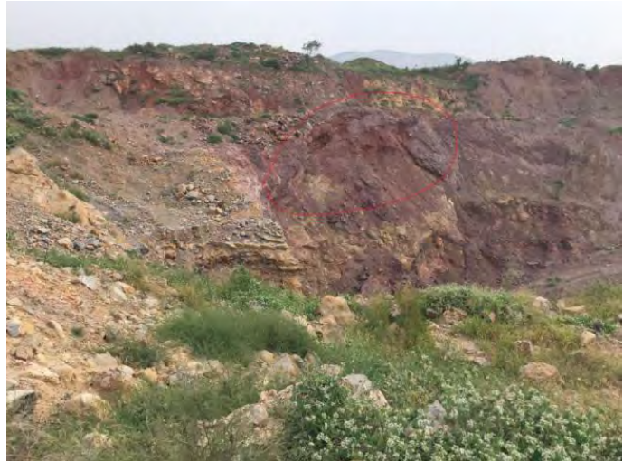
照片 5-13 CK5 崩塌堆积体
