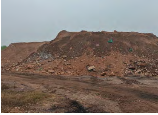
照片 5-14 区有表土堆场
