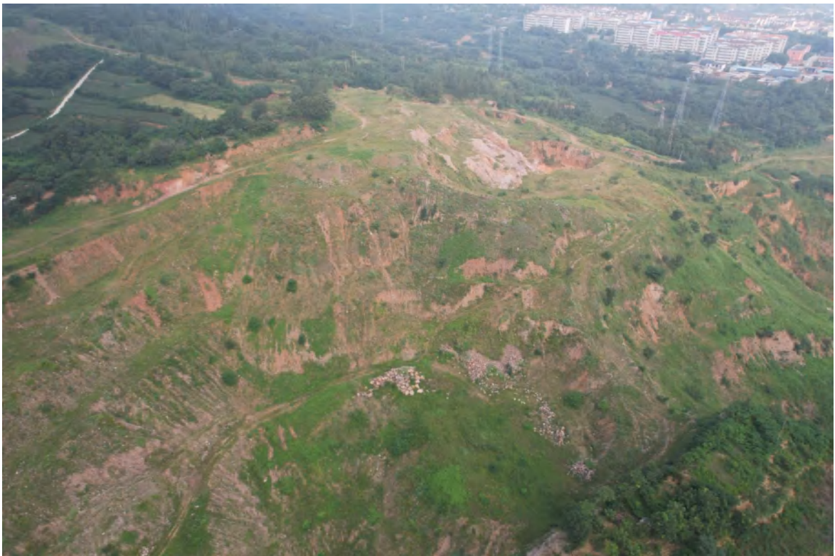
照片 6-2 已削坡降坡边坡及覆绿渣堆
