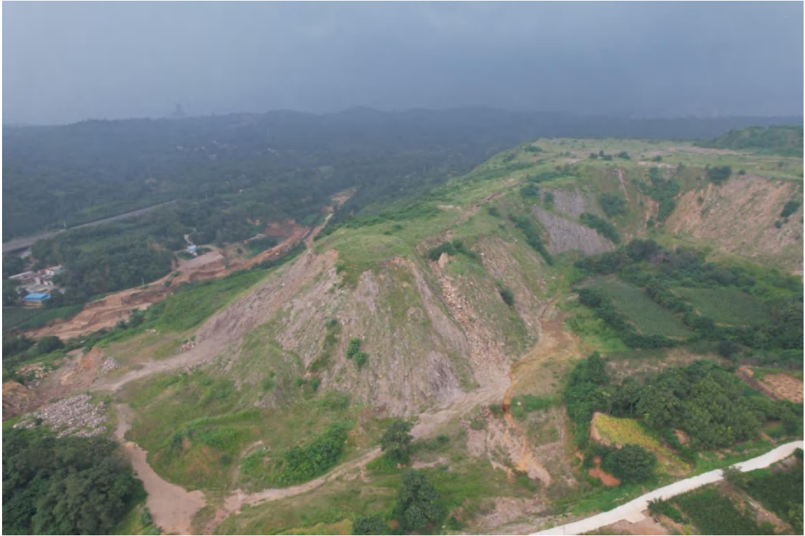
照片 6-3 已削坡降坡边坡及覆绿渣堆
