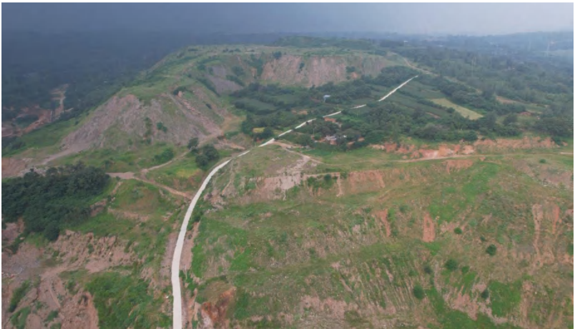
照片 6-5 已治理 8#损毁区现状
