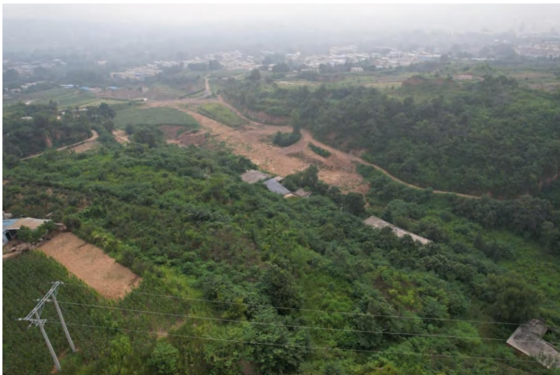
照片6-5 已治理2#损毁区现状
