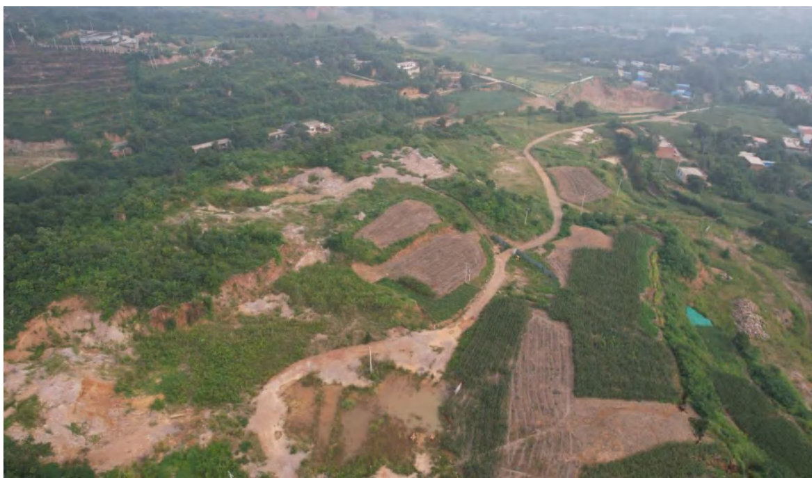
照片 6-6 已治理 3#损毁区现状
