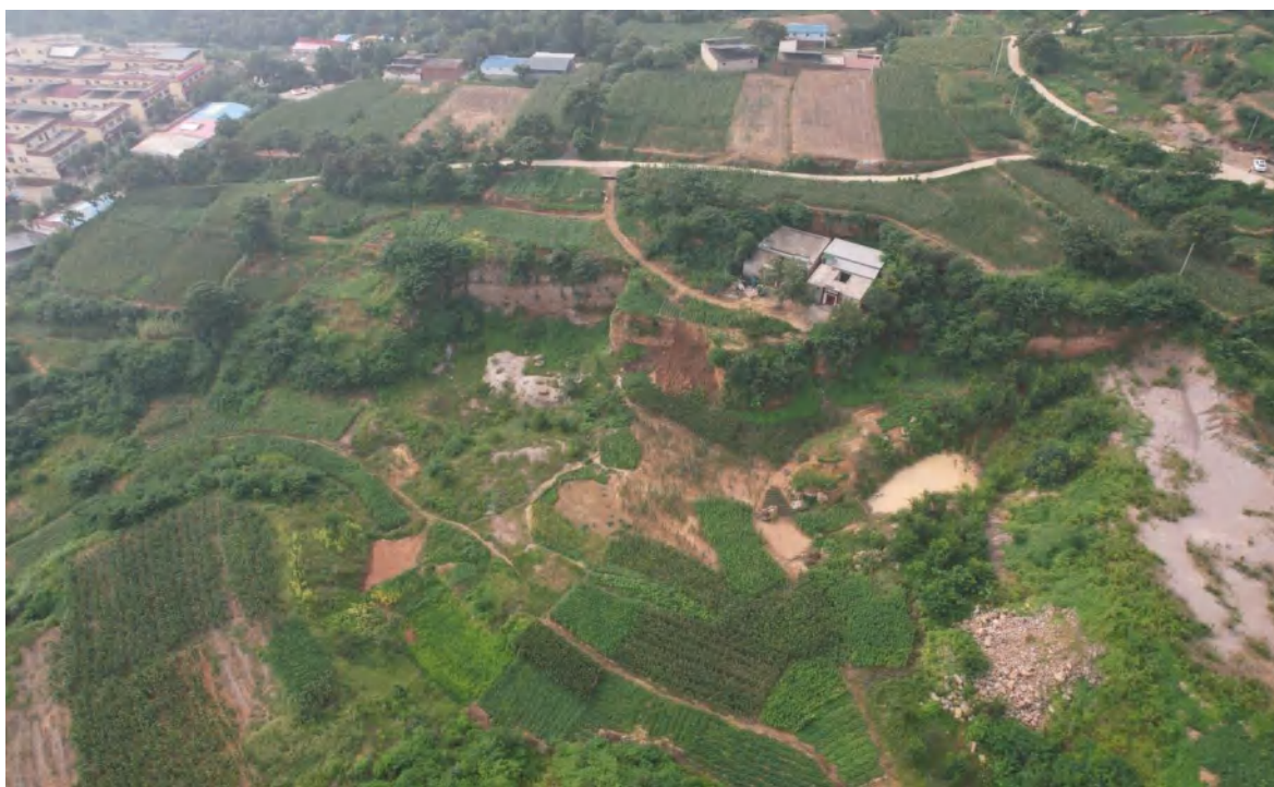
照片 6-8 已治理 5#损毁区现状
