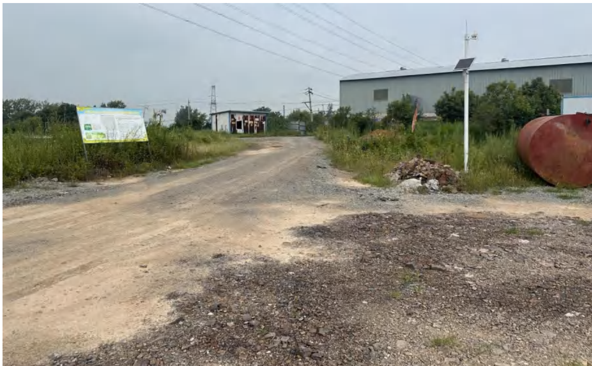
照片 6-9 已治理 6#损毁区现状
