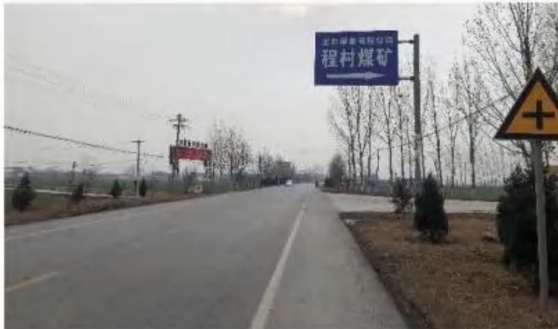
图 1-12 薄亢公路现状照片
