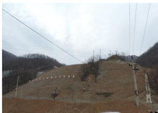
图 6-9PD900 工业场地(坡面已治理)
