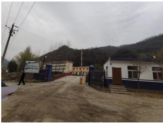
图 6-14 办公生活区（坡面已治理）
