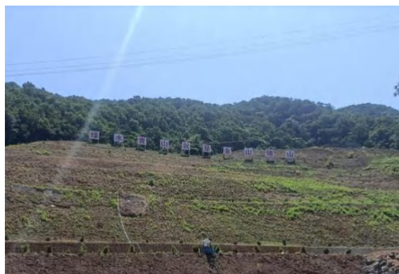
图 6-11PD924 工业场地（坡面已治理）
