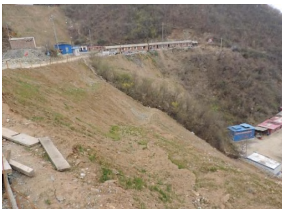
图 6-6PD930 工业场地（坡面已治理）
