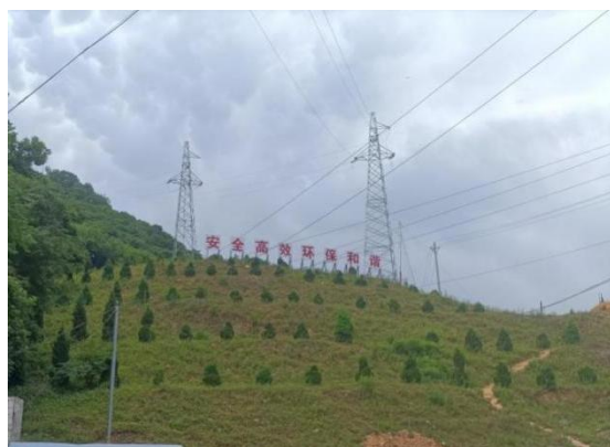
图 6-13PD730 工业场地（坡面已治理）
