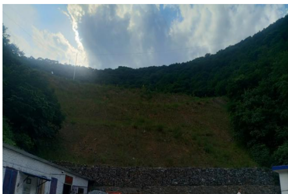
图 6-8PD960 工业场地（坡面已治理）
