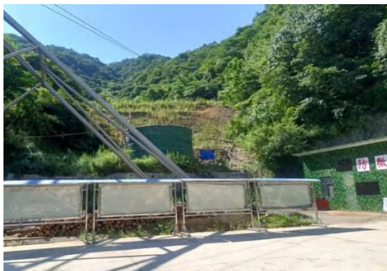
图 6-10 西沟竖井工业场地（坡面已治理）
