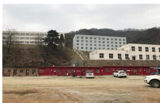
图 6-12PD991 工业场地（坡面已治理）
