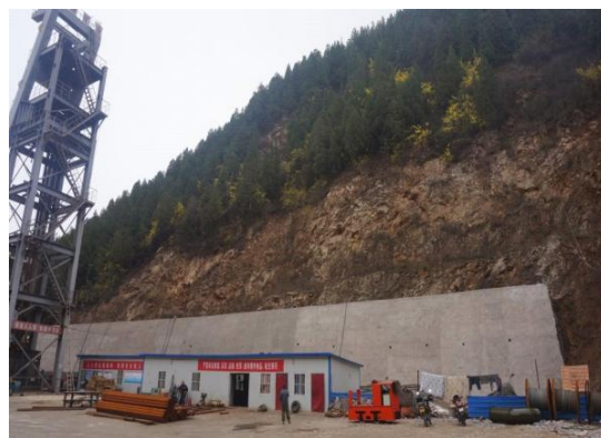
照片 6-16 秦南竖井护坡工程
