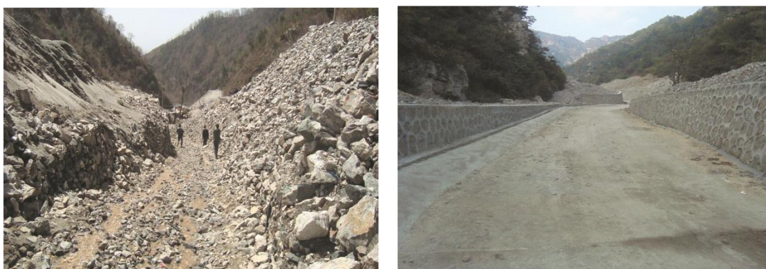
照片 6-11~6-12 朱家峪矿区工程治理前后对比照片
