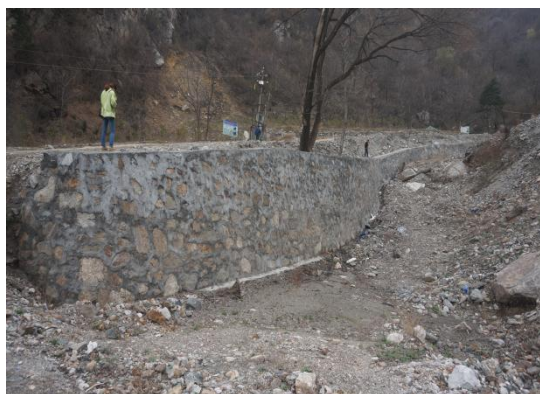
照片 6-15 大湖东峪 26 坑河道防护堤
