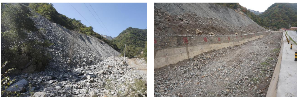
照片 6-13~6-14 王家峪 11 号挡渣墙治理前后对比照片
