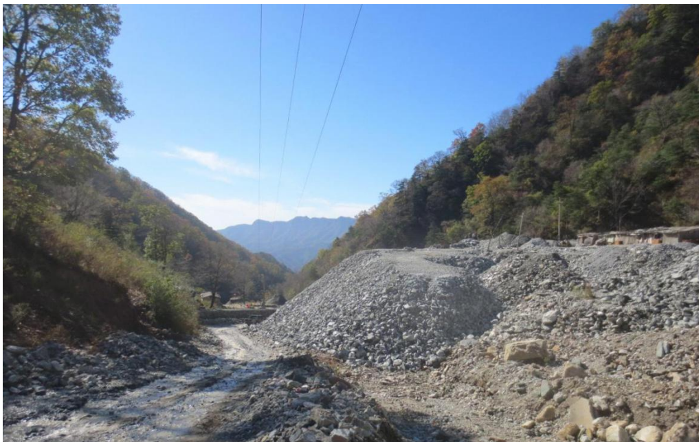
照片 6-2 矿渣堆积在沟道
